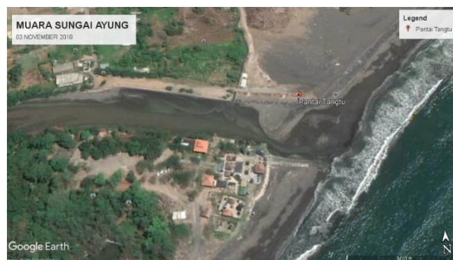
Gambar 11 : Kondisi hilir sungai Ayung terdapat pengendapan sedimen di mulut muara, dan kawasan pantai Padanggalak.
