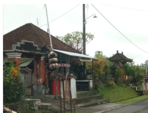
Gambar 3. Kasus pelanggaran di area telajakan (bangunan warung) Sumber : Dewi, 2017
