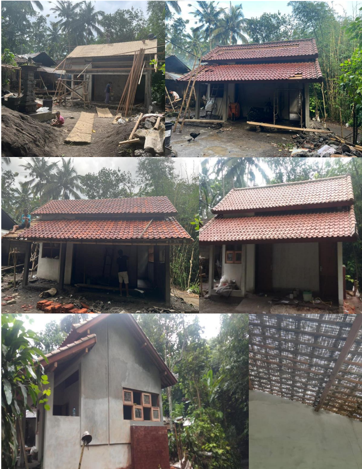
Gambar 4. Proses Pelaksanaan Bedah Rumah Dari Tahap Awal Sampai Akhir
