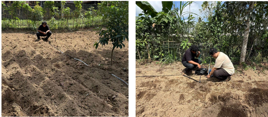
Gambar 5 Pemasangan Pompa dan Jaringan Pipa Tetes
