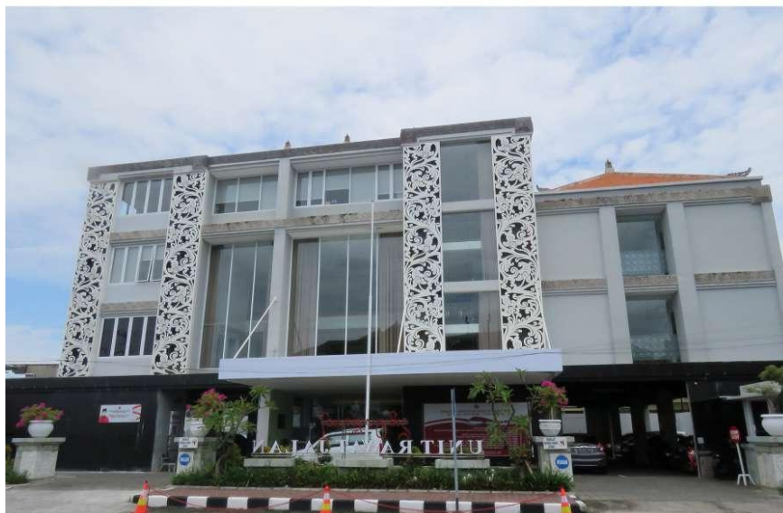
Gambar 1. Kondisi Eksisting Mitra di RS Puri Raharja
